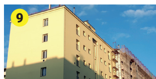
9 Sanierung Gemeindebau Lorystraße 54-60 95 Wohnungen auf 8.800 m 2 und PV-Anlage
