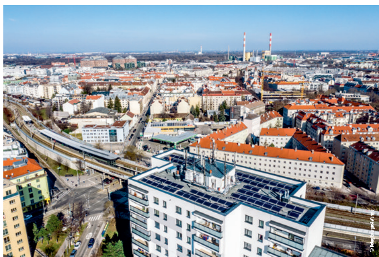
Photovoltaik-Anlage am Dach von Stiege 1.
